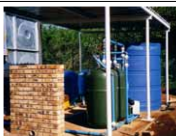
MiniPak 700: External Dimensions de l'unité : H- 1800 mm, Larg :1000 mm, Longueur : 1250 mm.
